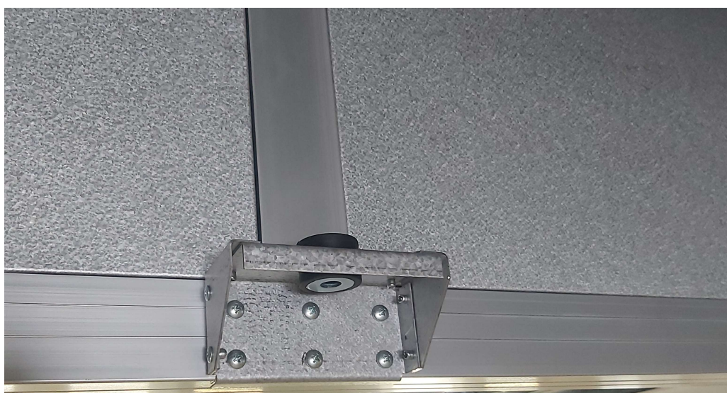
Рис. 5. Елемент кріплення установки до стелі.
