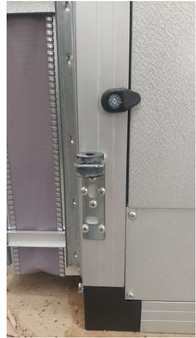
Рис. 6. Елемент кріплення приставного модуля до стелі.
